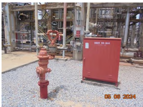
หัวจ่ายน้ำแบบมีหัวน้ำดับเพลิงชนิดติดอยู่กับที่ (Water Hydrant & Monitor)
