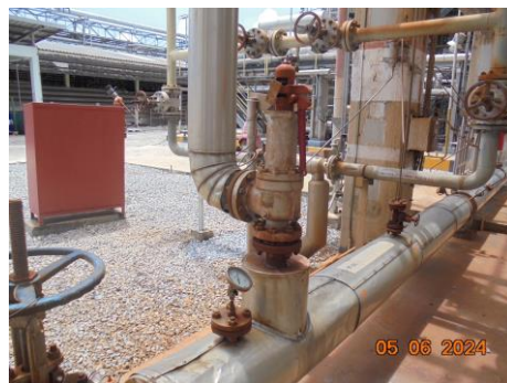
ภาพที่ 2.2-34 อุปกรณ์วาล์วระบายความดัน Pressure Relief Valve
