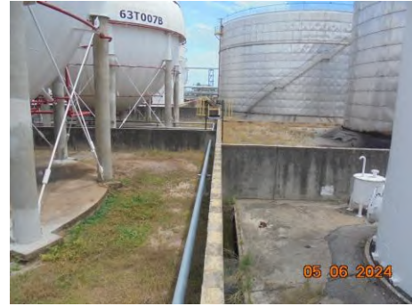
ภาพที่ 2.2-26 Bund Wall ป้องกันการหกรั่วไหลของสารเคมี
