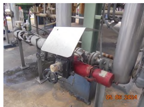
ภาพที่ 2.2-32 อุปกรณ์วาล์วตัดแยกระบบ Emergency Isolation Valve
