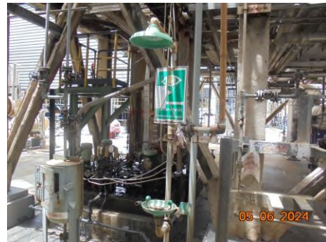
อ่างล้างตาและฝักบัวฉุกเฉิน (Eye Shower)
