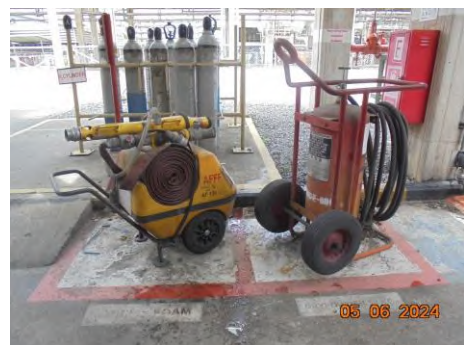
ถังโฟมดับเพลิงเคลื่อนที่ (Portable Mobile Foam)
