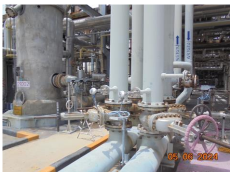
ภาพที่ 2.2-33 ระบบปั๊มที่ใช้ในการสูบน้ำ Pump Transfer
