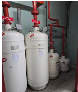
ระบบดับเพลิงก๊าซเฉื่อย (Inert Gas)
