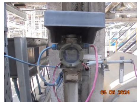
ภาพที่ 2.2-30 อุปกรณ์วัดอุณหภูมิ Temp Indicator
