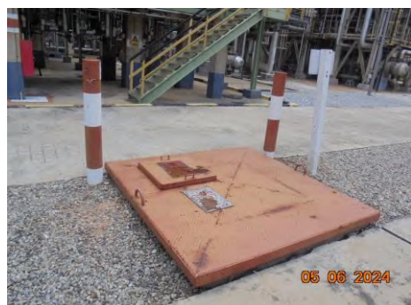
วาล์วน้ำดับเพลิง (Valve Pit)
