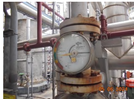
ภาพที่ 2.2-28 อุปกรณ์วัดอัตราการไหล Flow Rate
