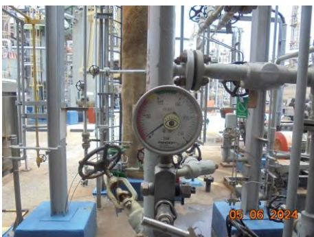
ภาพที่ 2.2-29 อุปกรณ์วัดความดัน Pressure Indicator
